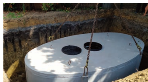
Cuve à eau
