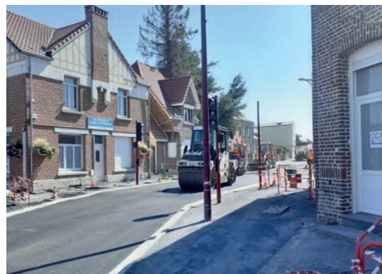
Travaux rue Jean-Jaurès
